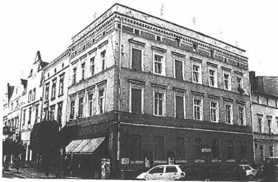
Fot.3/10. Kamienica Rynek 1, narożnik południowo wschodni (widok od wschodu).
