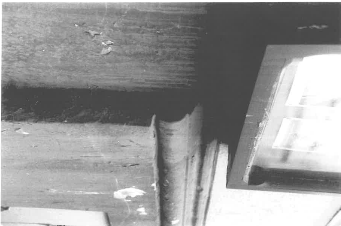
Fot.10/10. Kamienica Rynek 1, elewacja wschodnia - detal profilu cokotu.
